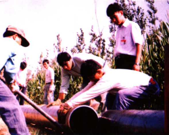
河北新奥集团天然气工程施工现场。
