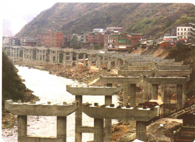
在建中的水(富)——麻(柳湾)高速公路 (柴俊峰 摄)
