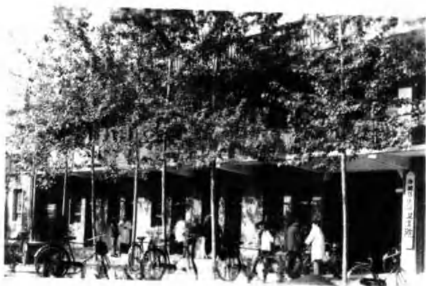
济源县承留卫生院
