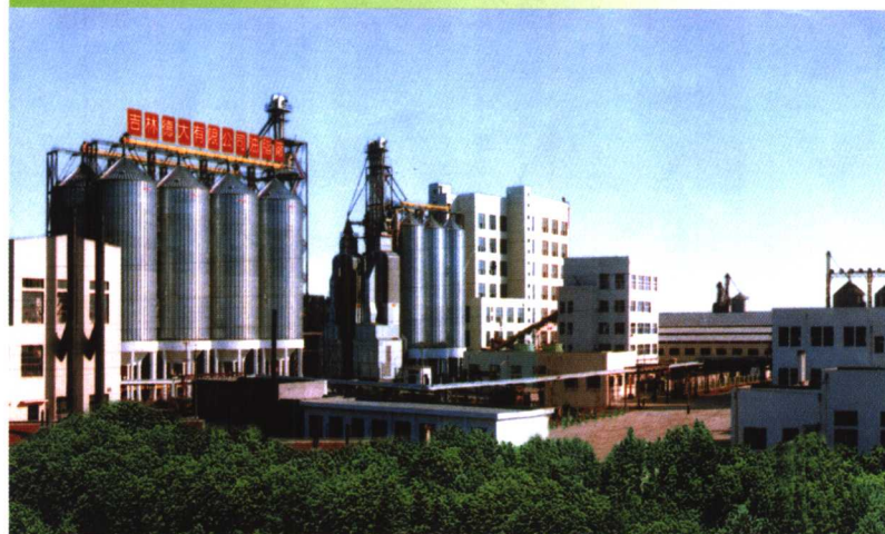
吉林德大有限公司油脂厂
