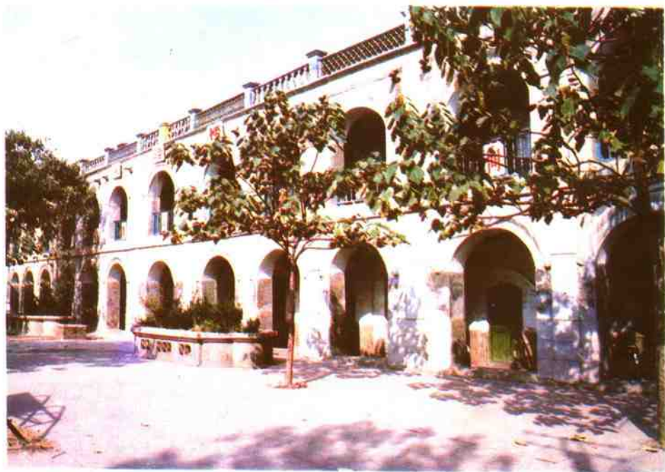
原河南省立第二中学教学楼
