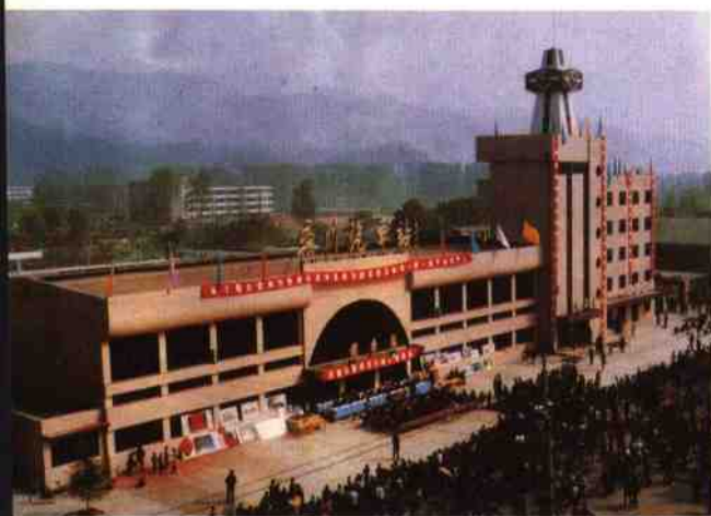
巍巍伏牛山下，新建的 栾川县汽车站为这座山城 增添了又一景观
