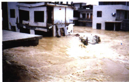
安乡县造纸厂堤段溃口近景
