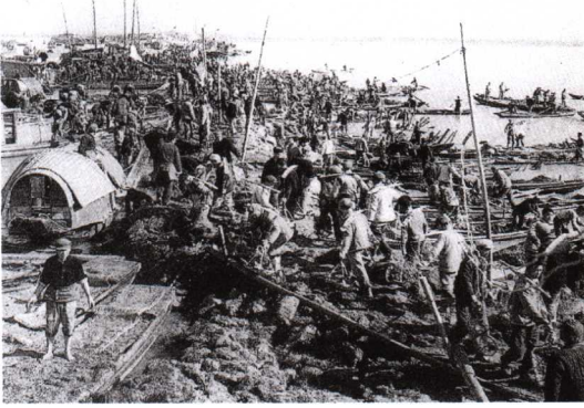
上图为 20 世纪 60 年代，湘阴县城西垵水灾后堵口复堤的情景
