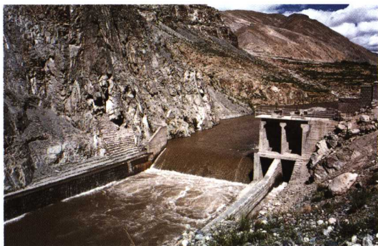
尼木县塔荣电站引水渠进口
