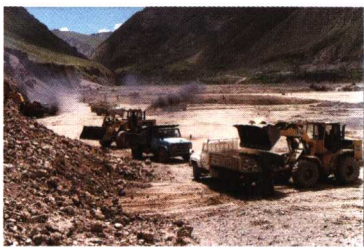
琼结县琼果水库工地
