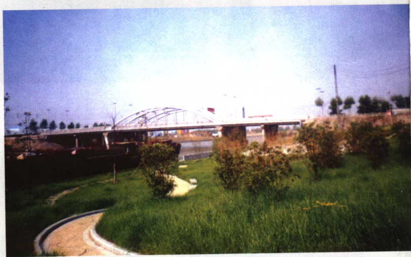
淮安运河大桥。
