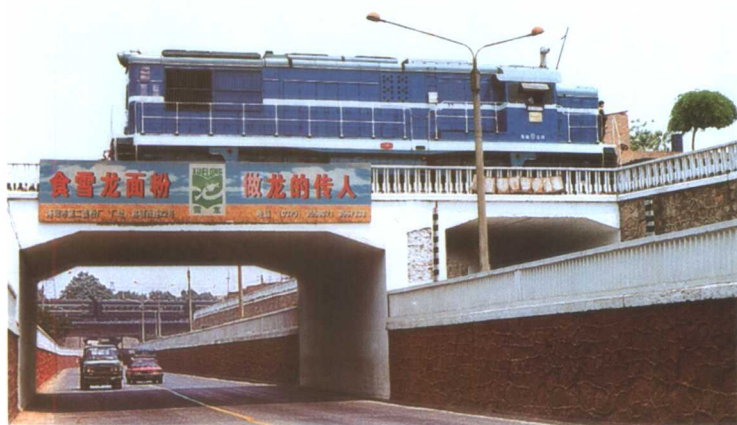
☆东花坛立交桥
