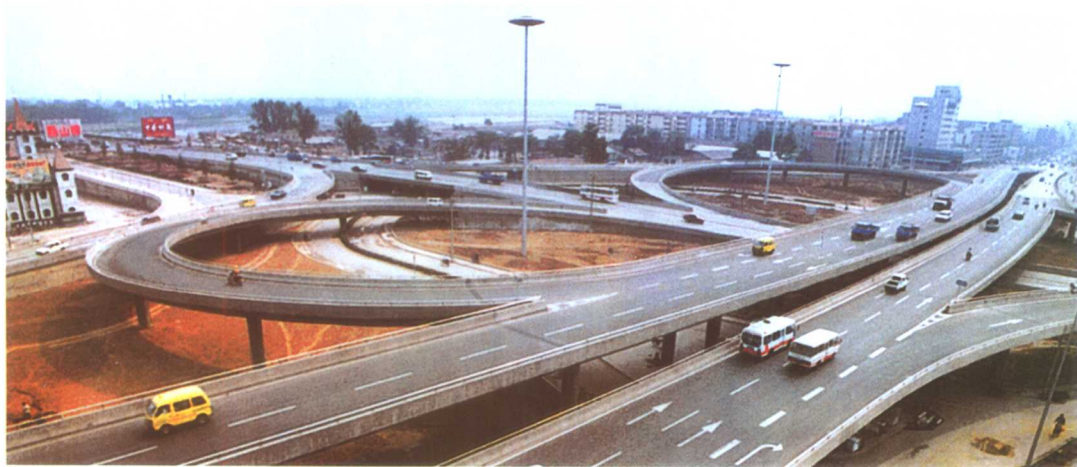
☆定鼎南路立交桥
