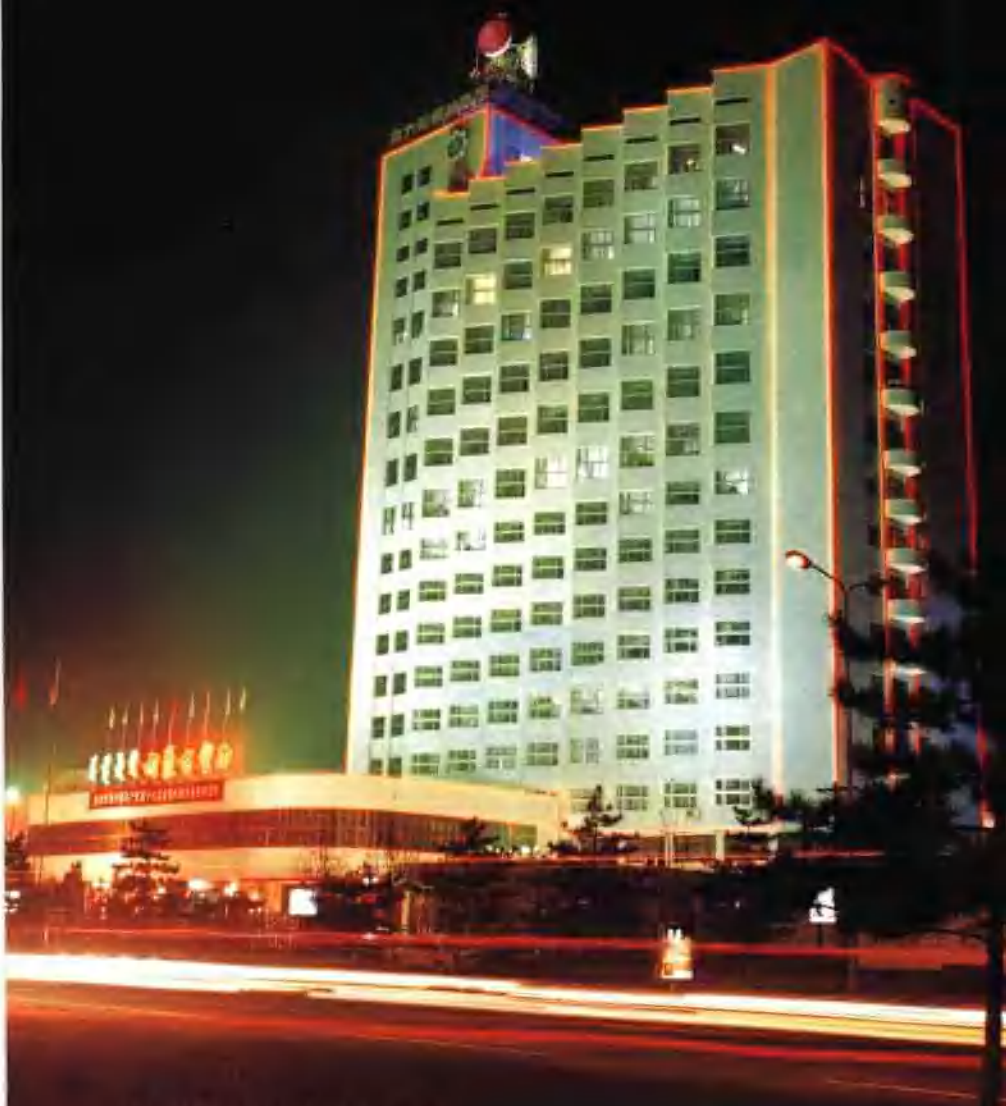
内蒙古自治区电力调度大楼
