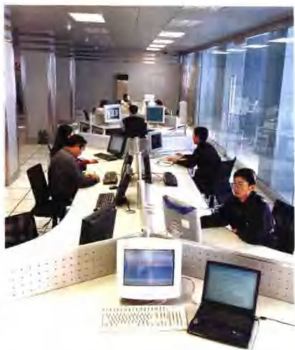
内蒙古 西部电网通 信调度
