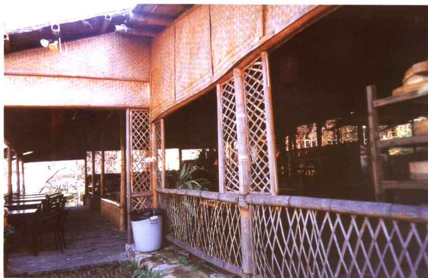
▲ 彩图 1-8 用竹建造的餐厅, 充满原始自然的味道
