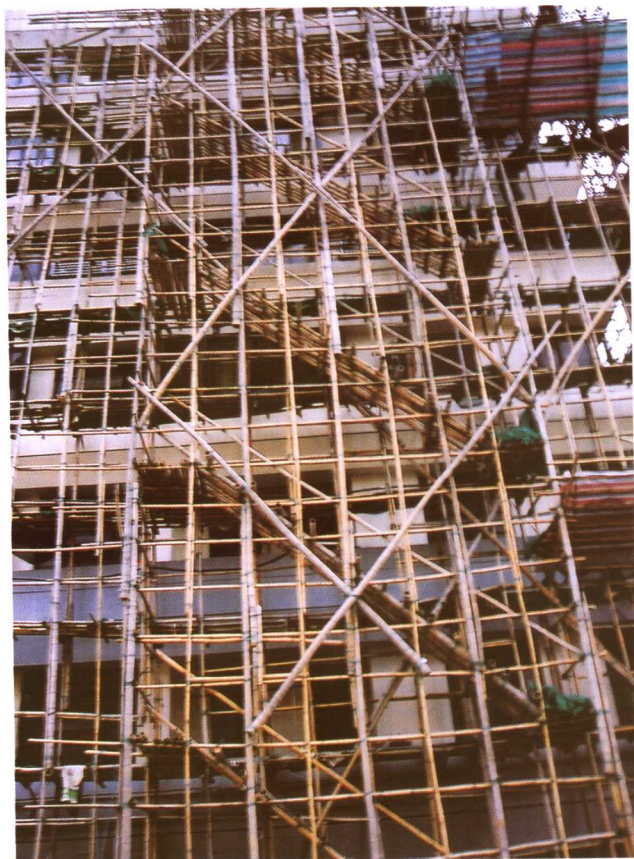
◀ 彩图 1-12 竹材在建筑施工中被用于搭建脚手架
