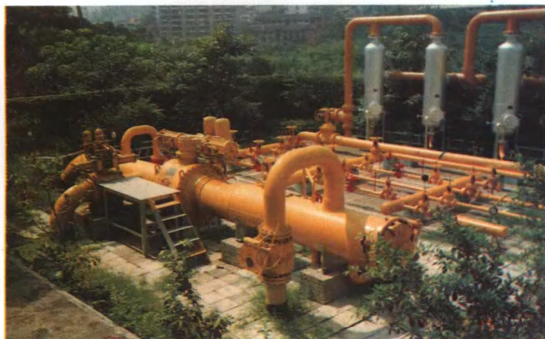
自贡高压阀门总 厂生产的动力球阀、 气/液联动球阀、闸阀 等产品在黄骅穿越长 江工程集输站
