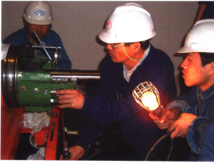
■ 岭澳核电站辅助给水泵检修
