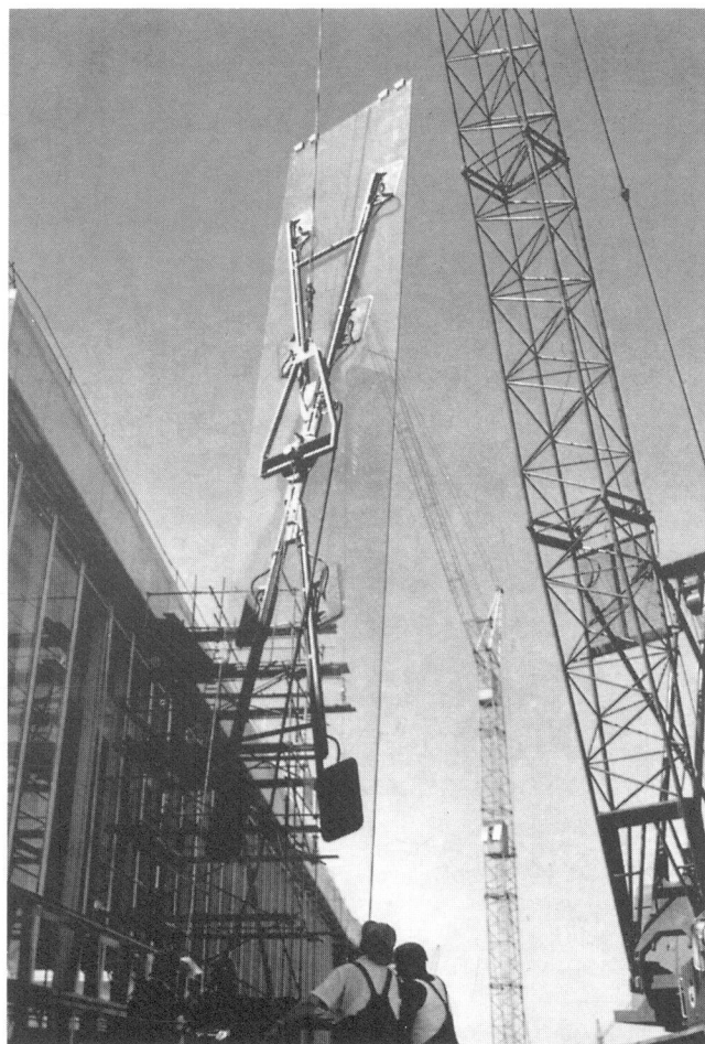
上图 包豪斯建筑中通透的转角 下图 哈恩玻璃悬挂系统
