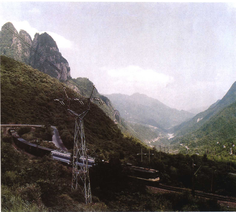
1961年8月，中国第一条电气化铁路宝(鸡)——风(州)段投入运行
