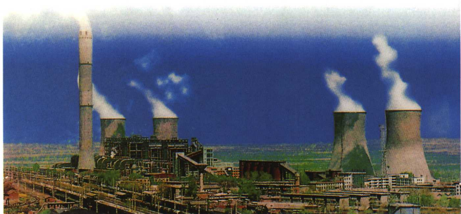
陕西第一座百万千瓦发电厂——秦岭发电厂(二期)
