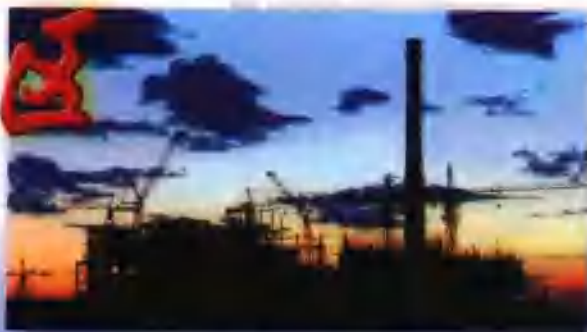
建设中的国家振兴东北老工业基地国储
