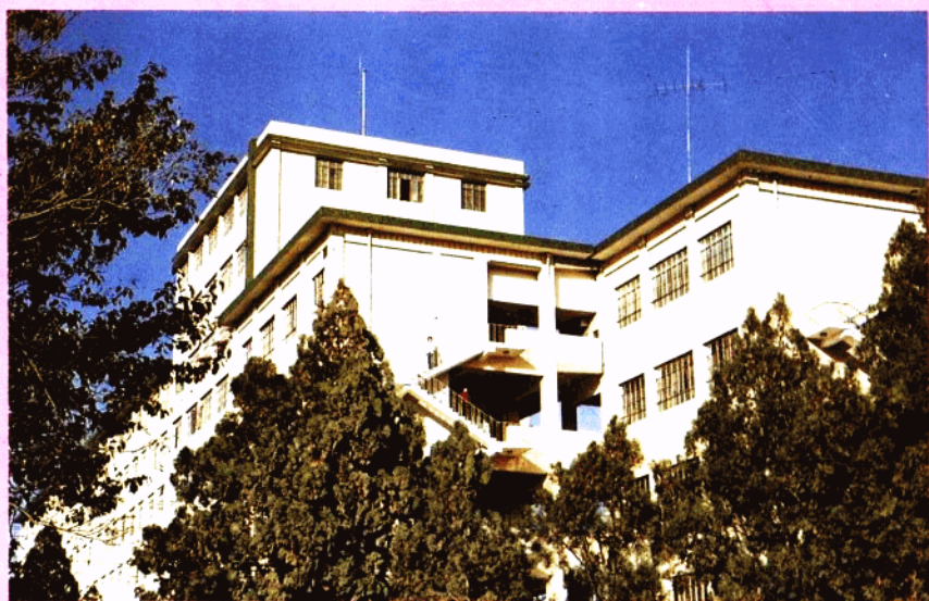
教学大楼东隅
