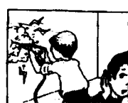
用冲击钻在墙上打孔
