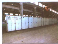
KYN28A-12 系列户 内交流金属铠装移 开式开关设备
