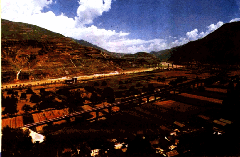
► 郑州黄河老桥在拆除中
