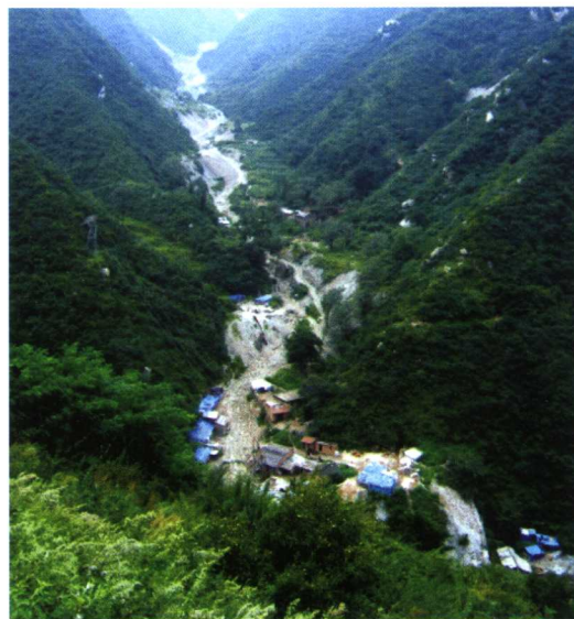
照片17~18 陕西潼关金矿区采矿废石随意堆积,沟沟存在着严重的矿渣型泥石流地质灾害隐患
