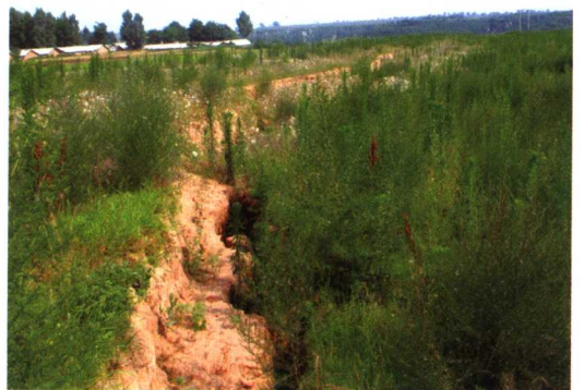
照片6 陕西黄陵店头煤矿地面塌陷造成良田荒芜
