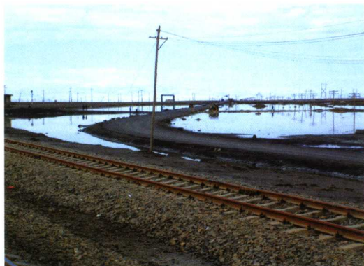
照片14 青海察尔汗钾盐生产排放的老卤水危及交通安全
