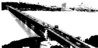
武汉长江大桥
