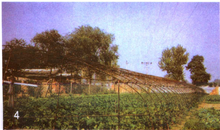
圆钢焊接 “人”字形 架大棚棚 头设置
