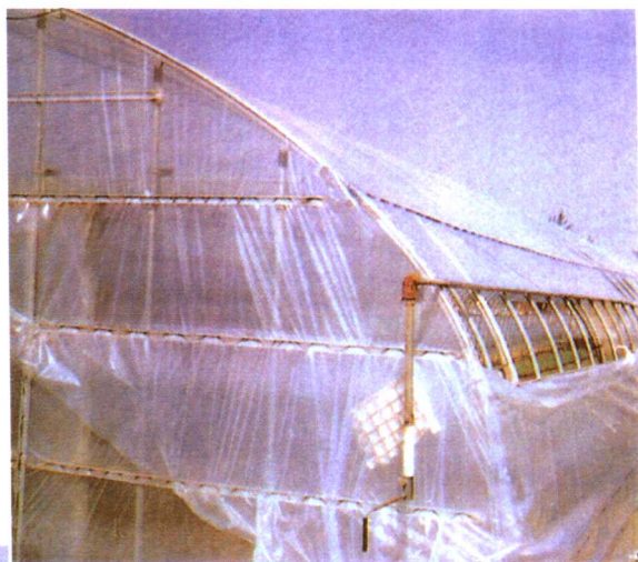
镀锌薄壁钢管大棚手 摇式侧缝开闭装置
