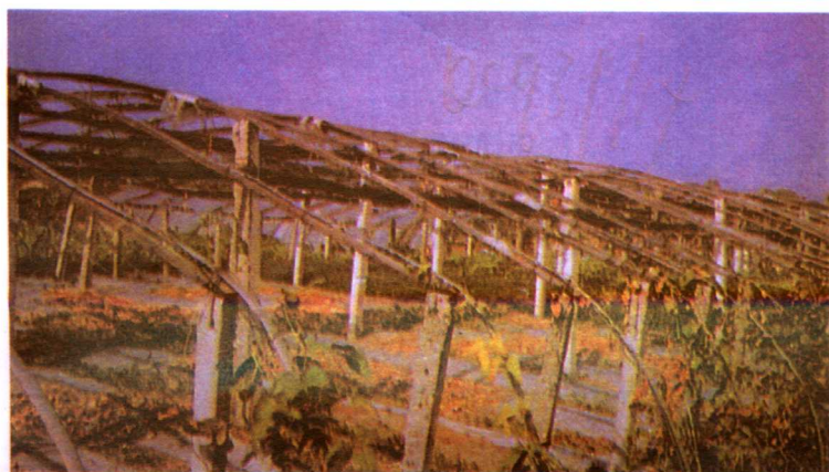
六排柱式 混合结构 大棚骨架 组装
