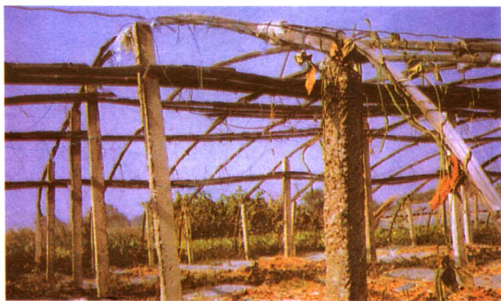
八排水泥 柱竹拱架 安装图
