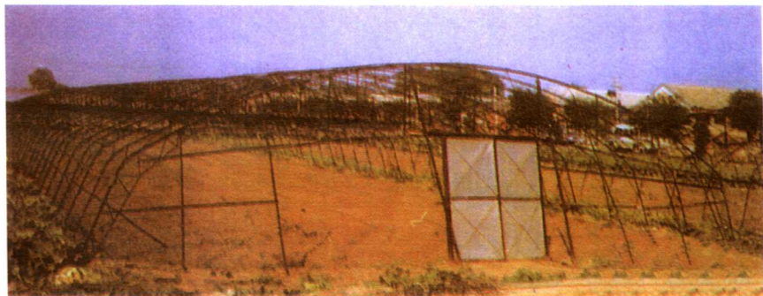
圆钢焊接半“人”字形拱架大棚外形
