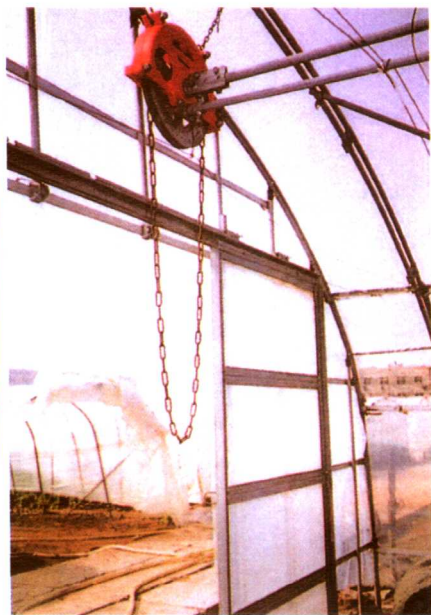
管架大棚二道幕开闭的拉 链葫芦盘及推拉门设置
