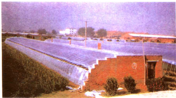
砖墙、钢柱、管架组装式 加温温室盖膜的下风口
