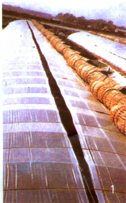
砖墙、钢柱、管架组装式加温温 室卷起蒲苫放置部位和上风口
