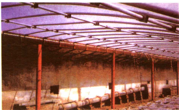
砖墙、钢柱、管架组装式 加温温室火道呈坡状
