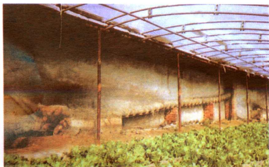
砖墙、钢柱、管架组装 式加温温室栽培玻璃脆 生菜(双拱杆)
