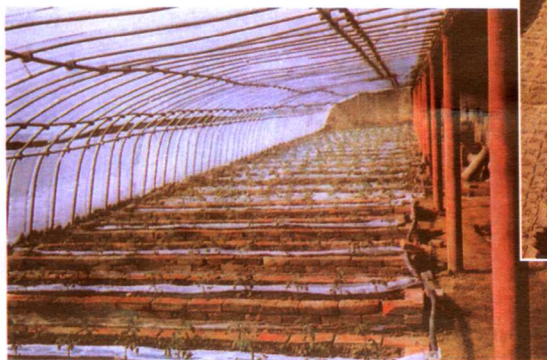
砖墙、钢柱、管架组装式加温温室基 质(无土)、滴灌、盖地膜栽培西红柿
