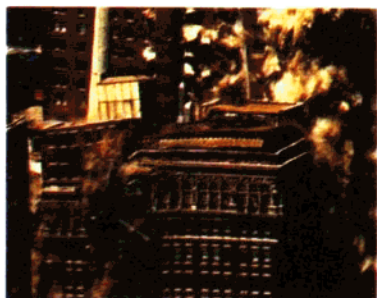
图 1-2-6 被地震毁坏的大厦
