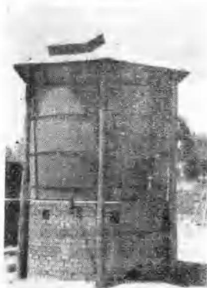
此种油罐的底部直径为2.00公尺，高2.00公尺，上部口的直径为2.30公尺，总的容积是6.437立方公尺。根据石油
