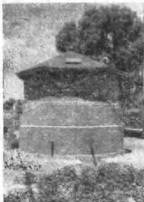
磚木結構的油罐，系根據石油工業部北京設計院設計的圖紙，我們加以修改建成的。
