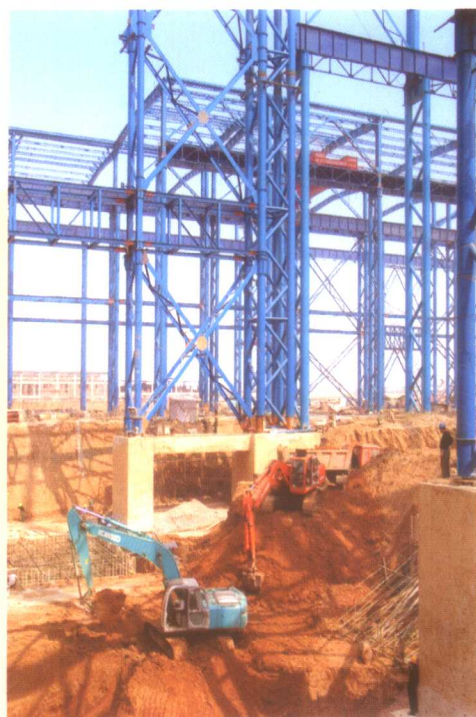
第二冷轧厂建设工地
