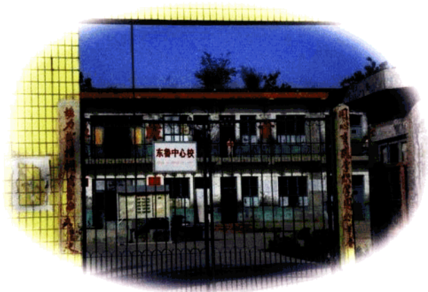
东鲁村正在修缮的漏雨的小学校舍
