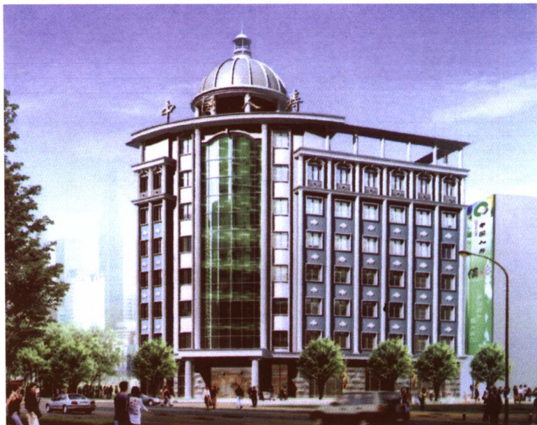
中国人寿南康市支公司 办公大楼
