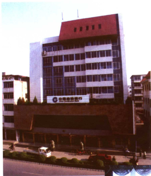
建设银行南康市 支行办公大楼
