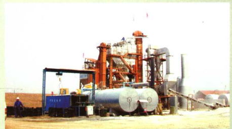
● 沥青混凝土拌和站
