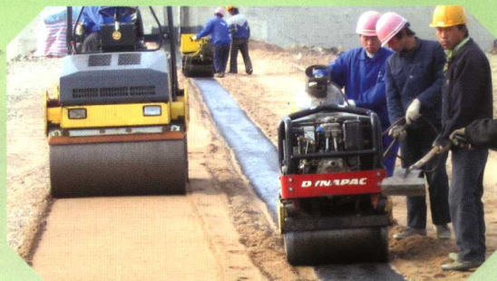
● 心墙及过渡料施工
