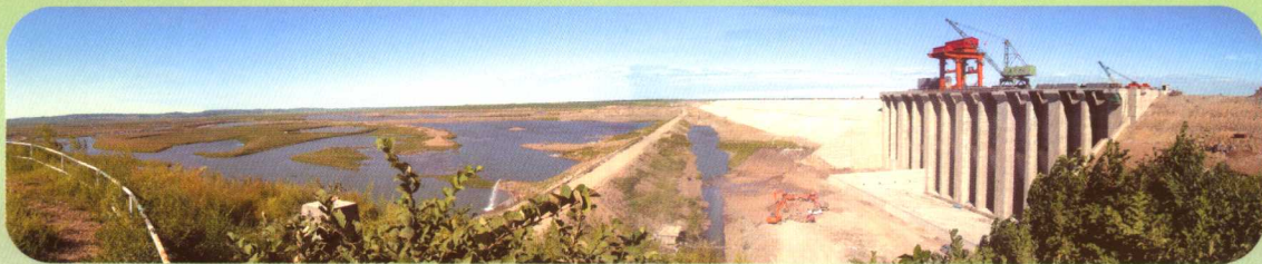
● 尼尔基水利枢纽上游施工全景
