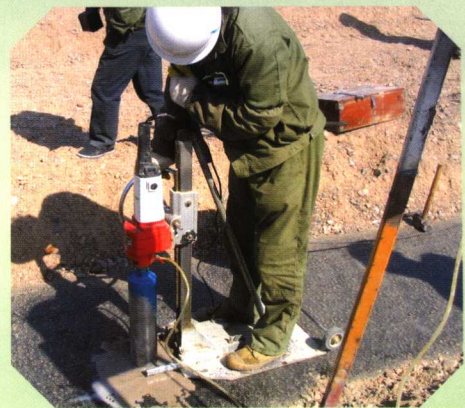
● 取沥青混凝土芯样
