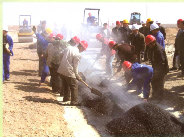
● 沥青混凝土人工摊铺
