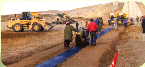
● 沥青混凝土心墙碾压施工
