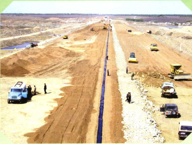
● 主坝碾压式沥青混凝土心墙施工
