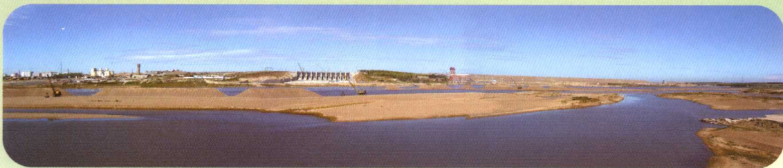
● 尼尔基水利枢纽下游施工全景
