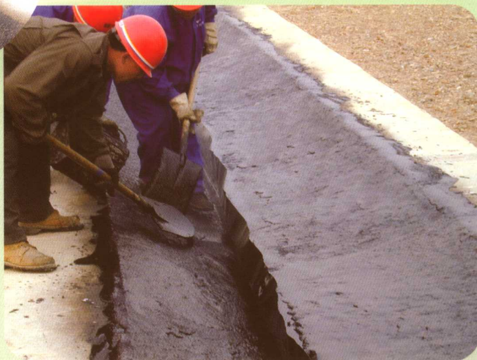
● 铺筑沥青玛蹄脂
