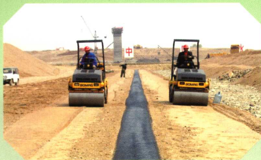
● 过渡料碾压施工
