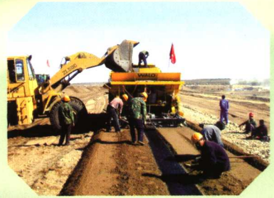
● 沥青混凝土摊铺机施工
