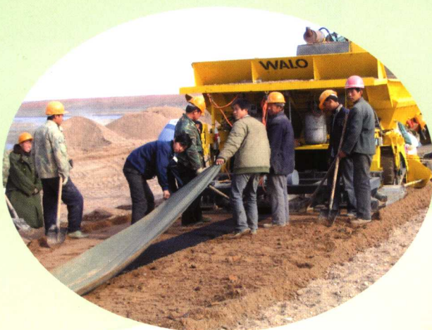
● 沥青混凝土心墙覆盖
