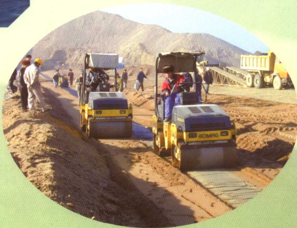
● 沥青混凝土心墙施工
