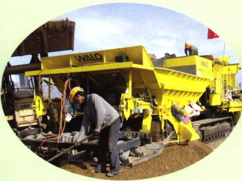
● 沥青混凝土摊铺施工
