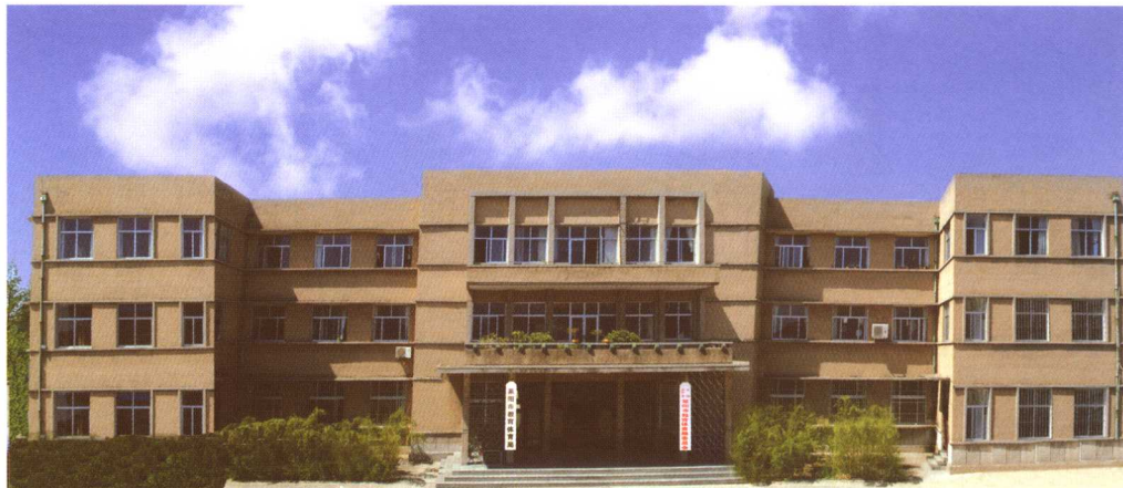
莱阳市教育体育局办公楼
