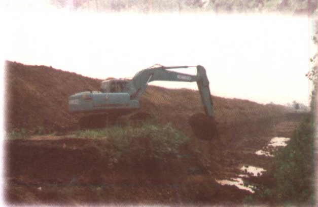
开挖的引水蓄水干渠正在施工
