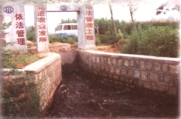
2002年修建的引水干渠节制闸
