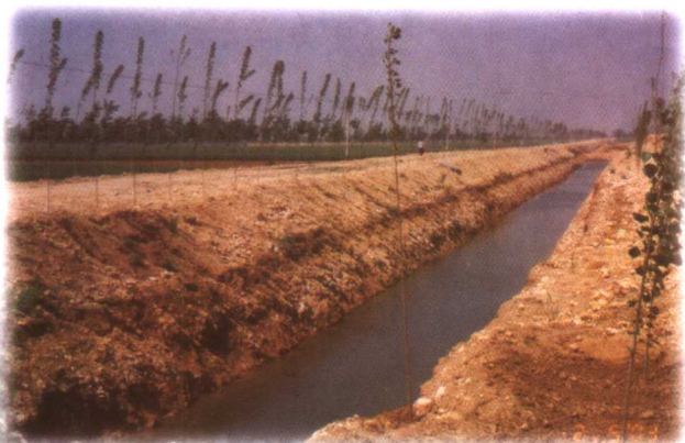
二郎庙沿农田开挖的5000米引水、蓄水两用干渠
