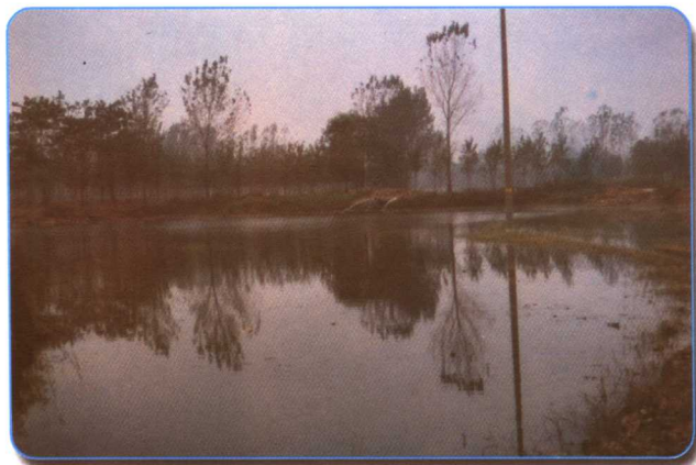
郭家沟村蓄水坝
