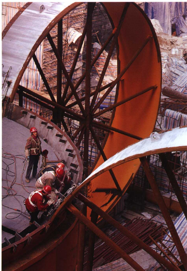
2006年春节，建设中的三峡右岸发电机组
