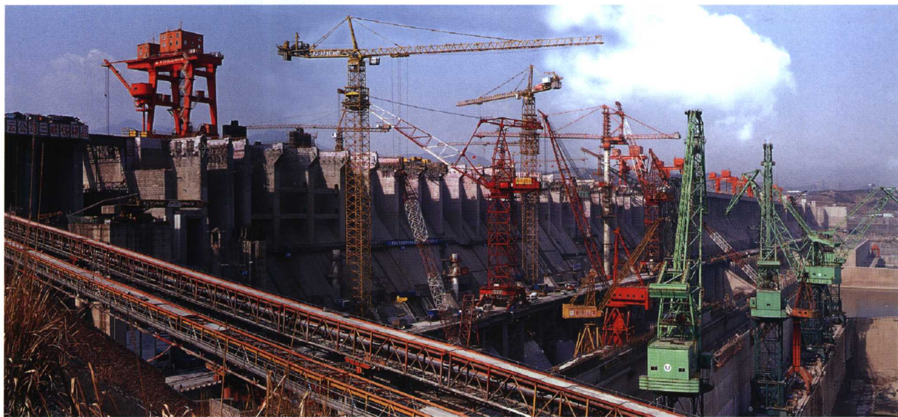
2006年3月，对接后的三峡左右岸大坝；5月，大坝全线到顶
