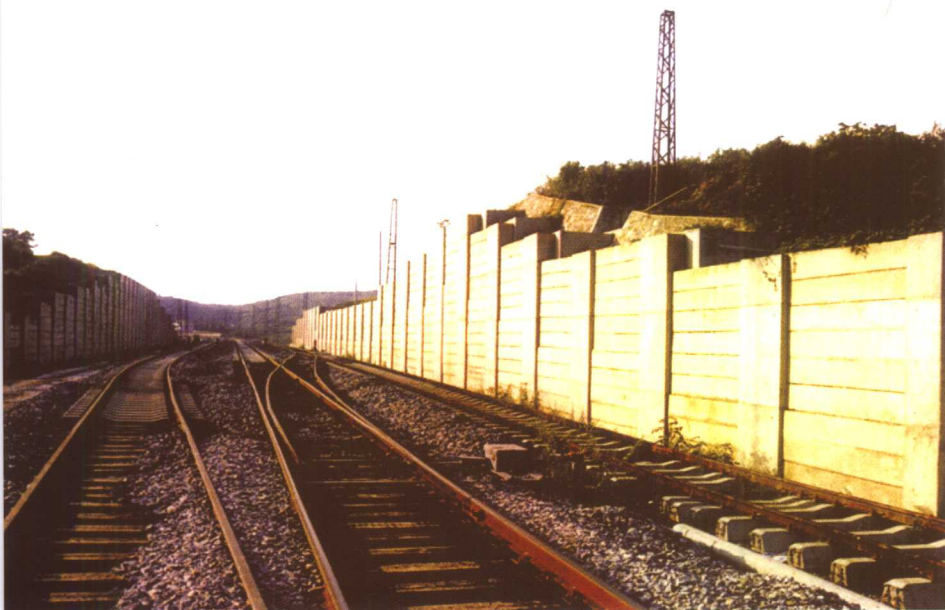
采用桩板式抗滑挡墙处理膨胀土
