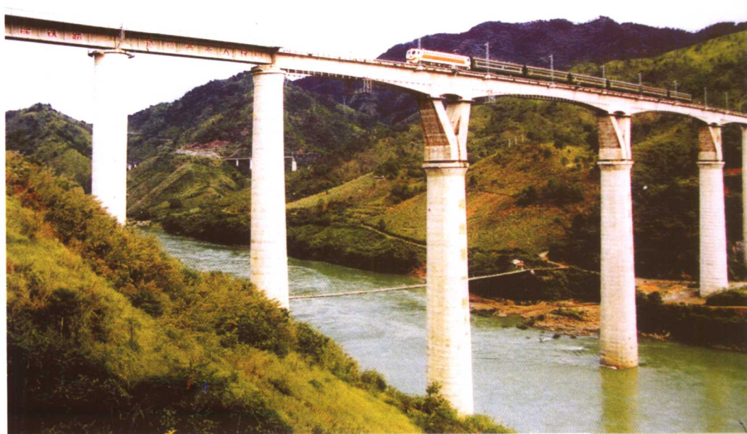
八渡南盘江特大桥
