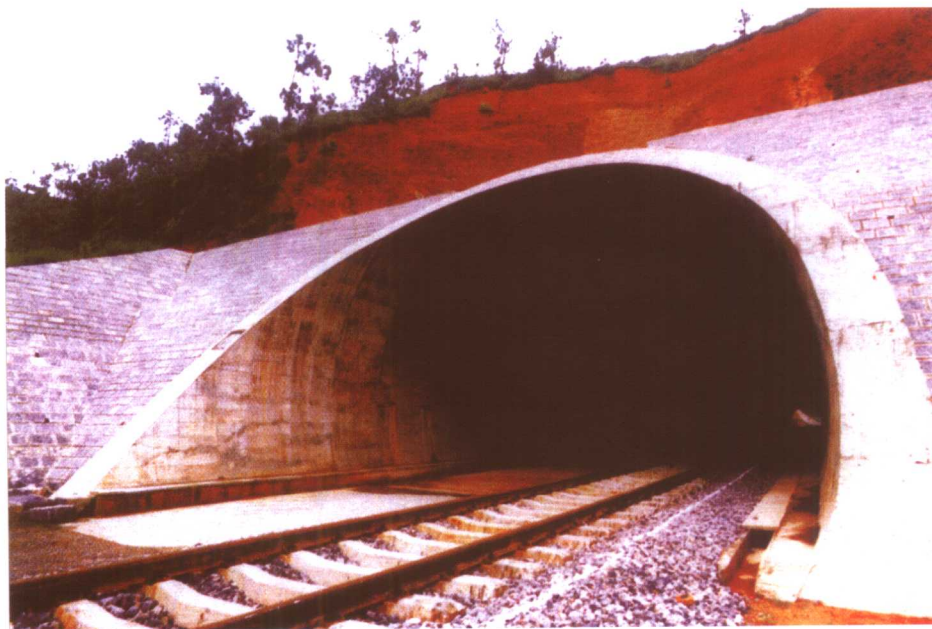
乐善村2号双线隧道
