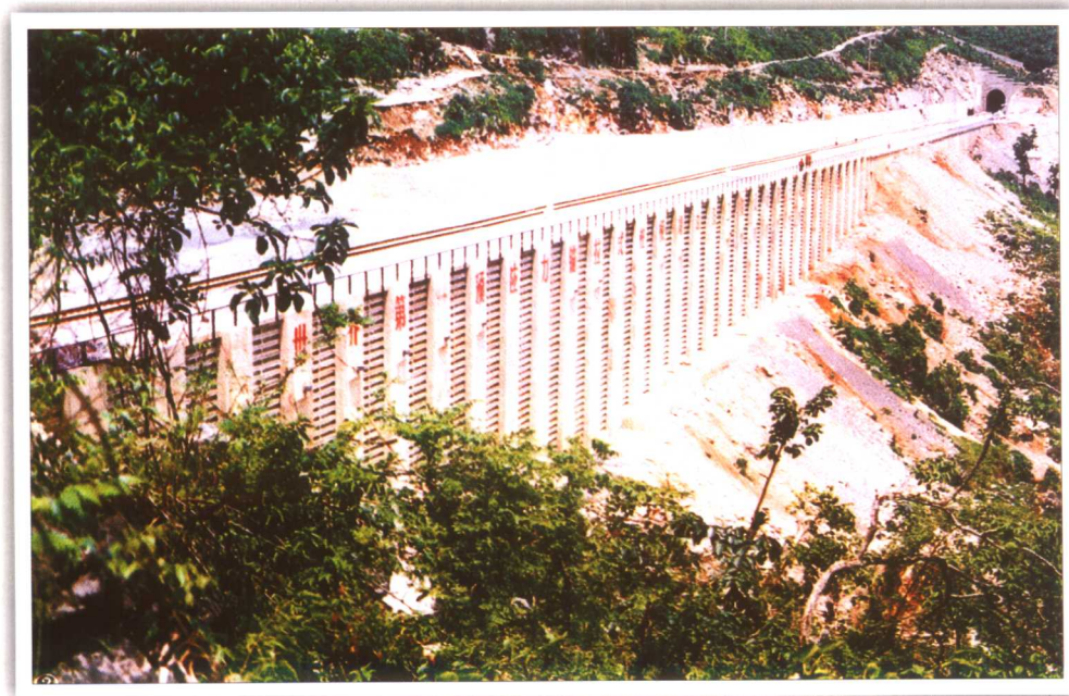
石头寨锚拉式桩板墙
