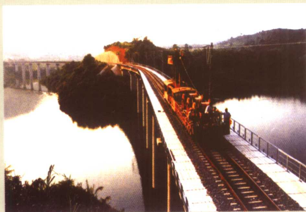
施工中的电气化工程
