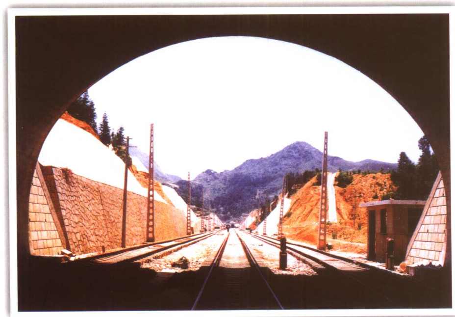
沙厂坪2号三线隧道
