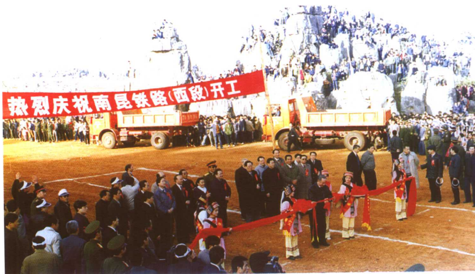
1991年12月19日，南昆铁路西段开工，标志全线建设全面展开
