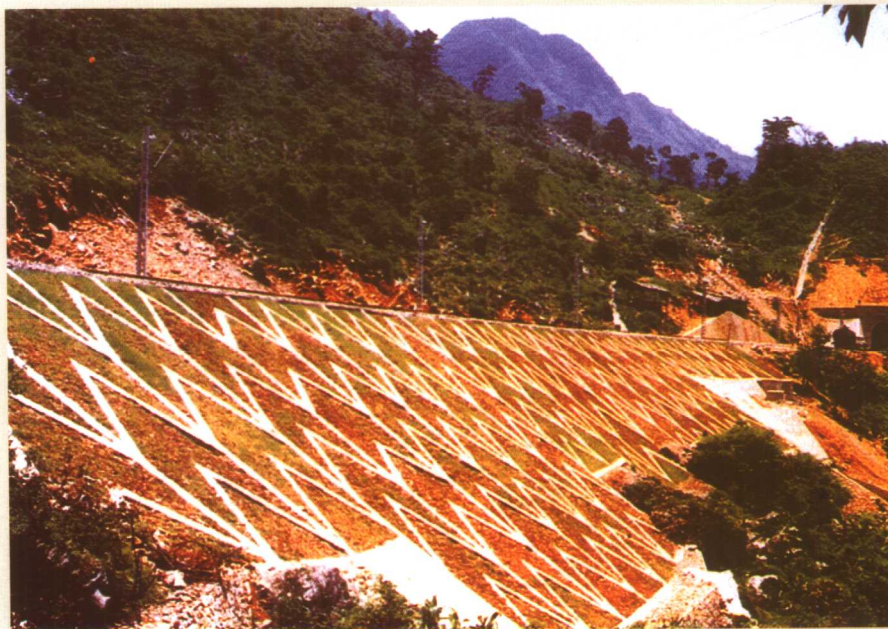
沙厂坪3号隧道出口路段骨架护坡防护工程
