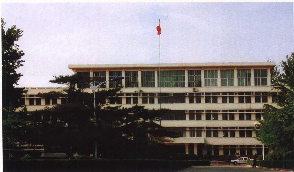
市政府办公大楼
