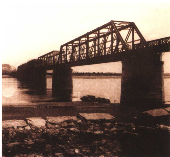
詹天佑首次引进气压沉箱法解决桥墩难题成功建成滦河铁桥
