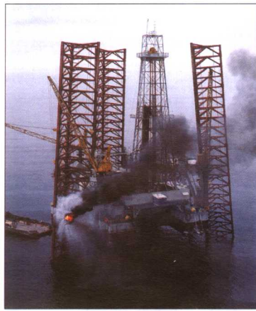
安哥拉近海石油勘探基地
