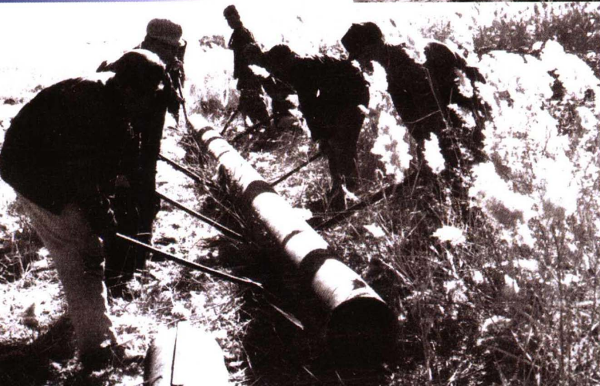
1958 年建成中国第一条长距离输油管道：克一独输油管道
