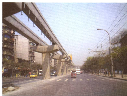
高架区间线路 2
