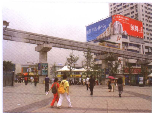
高架区间线路 6
