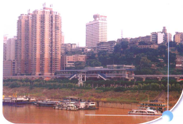
曾家园高架站
