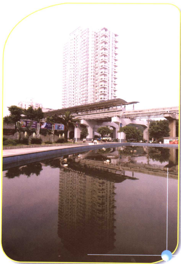
袁家岗高架站远景
