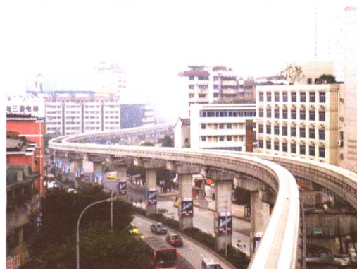
高架区间线路 4
