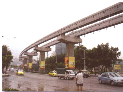
高架区间线路 1
