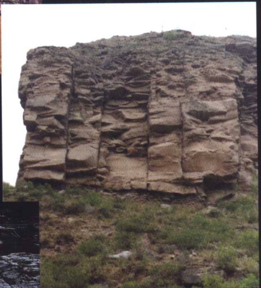
黄河宽谷河道 谷坡上的节理
