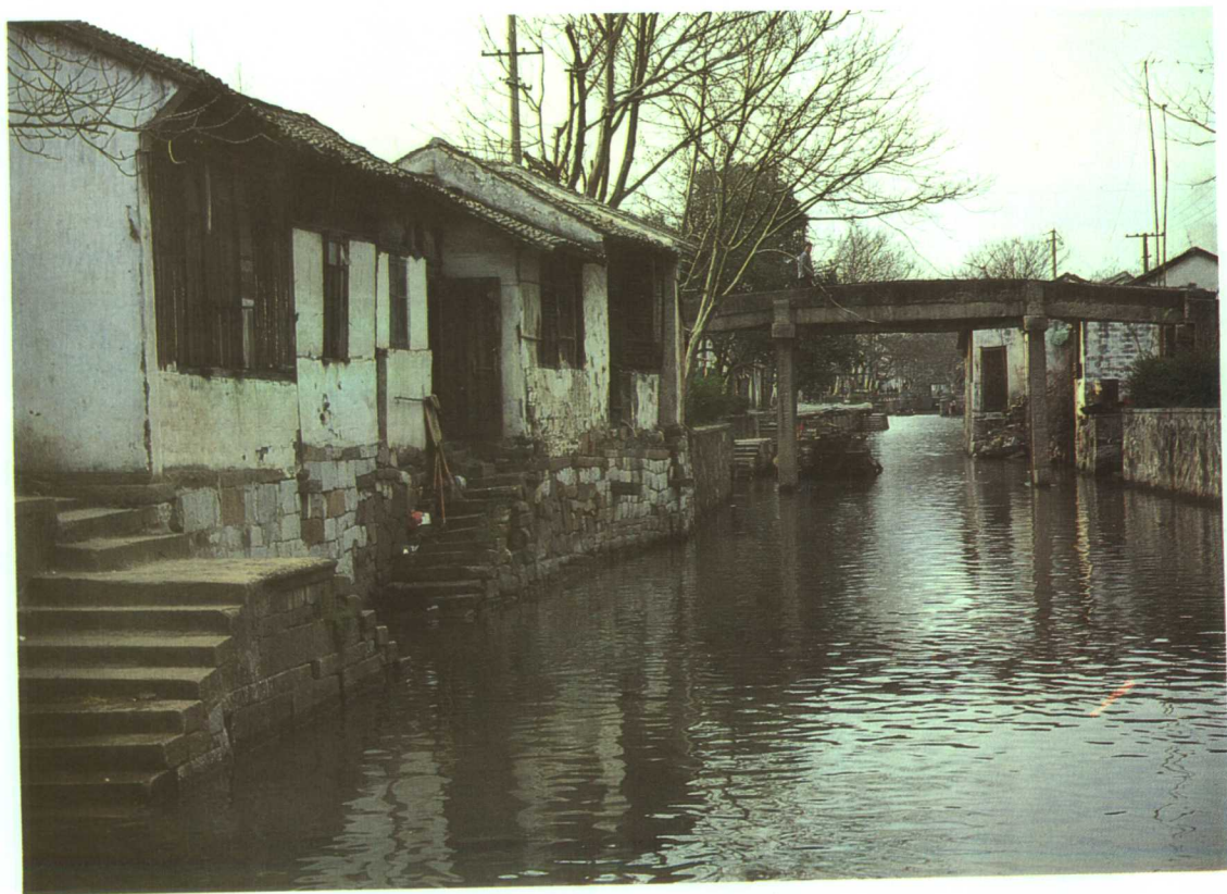
石埠桥横 南浔南安桥
