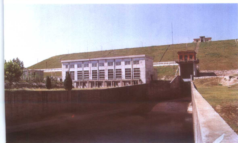
输水洞出口与 水电站厂房
