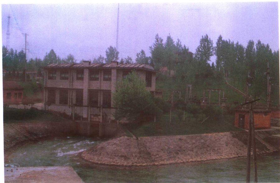
中干渠迎水寺岗水电站
