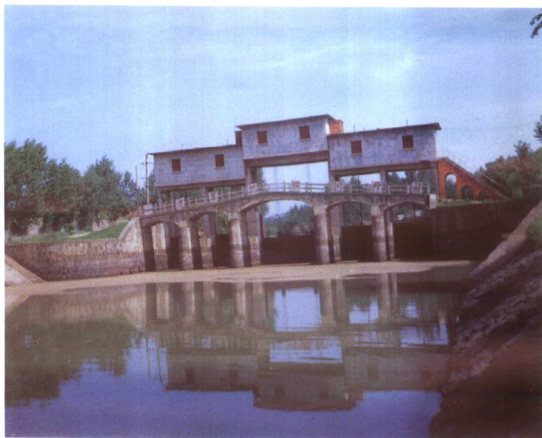
总干渠在东干渠分水闸处的节制闸
