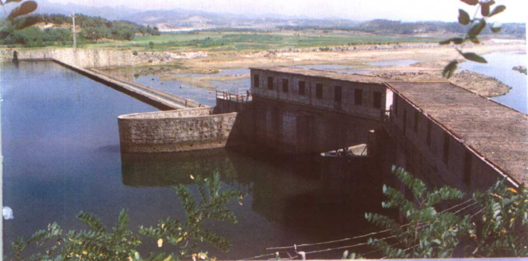
总干渠渠首枢纽
