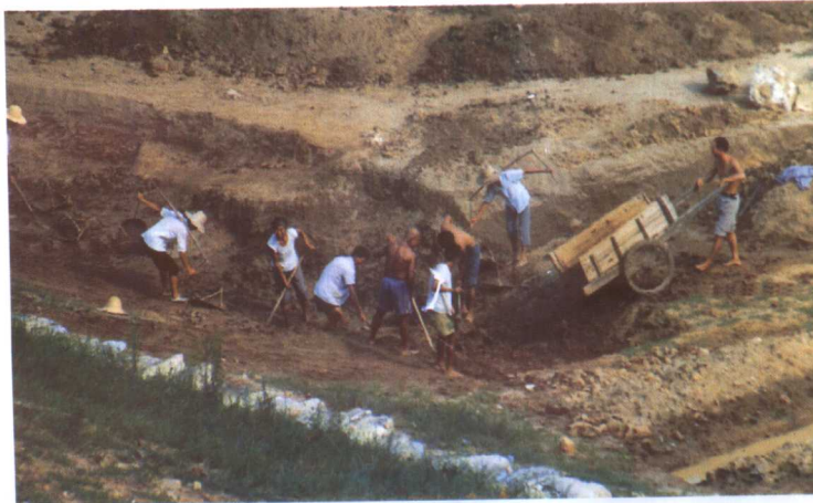
8号副坝加固施 工清理基础
