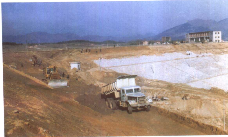
主坝加固施工
