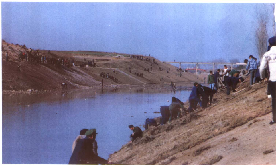
总干渠续建改造中的标准化整修
