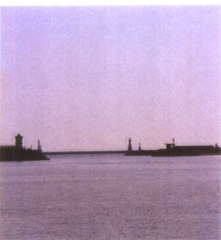
燈杆大部分設置在港口的防波堤上，以指示船舶進出港區航道。
