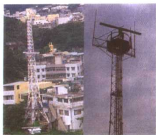
無線電標杆(左)及雷達標杆(右)是先進的助航設施，可以彌補燈塔的不足處，強化其維護船舶安全的功能。
