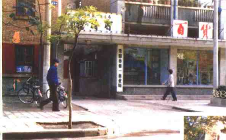
◀ 洛阳市第一商业局办公大楼
