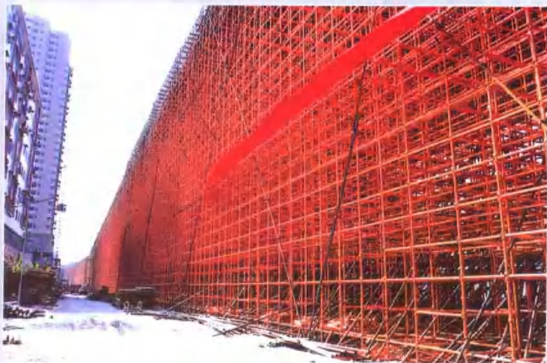
南田西路段的高支顶架实况
