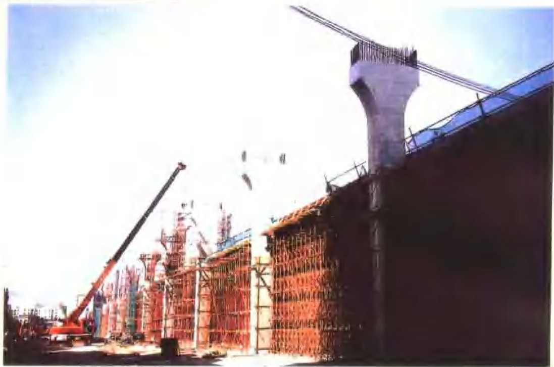
南田东路段在施工中
