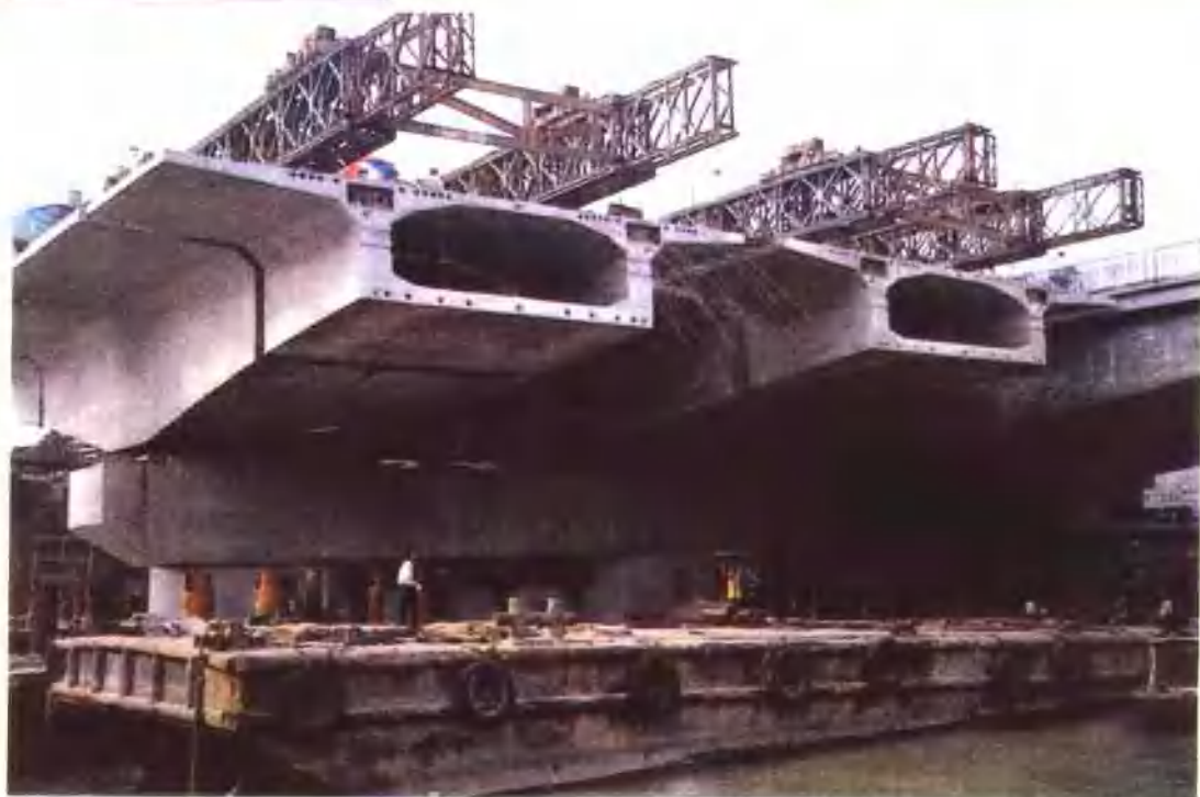
人民桥采用悬拼法施工实况
