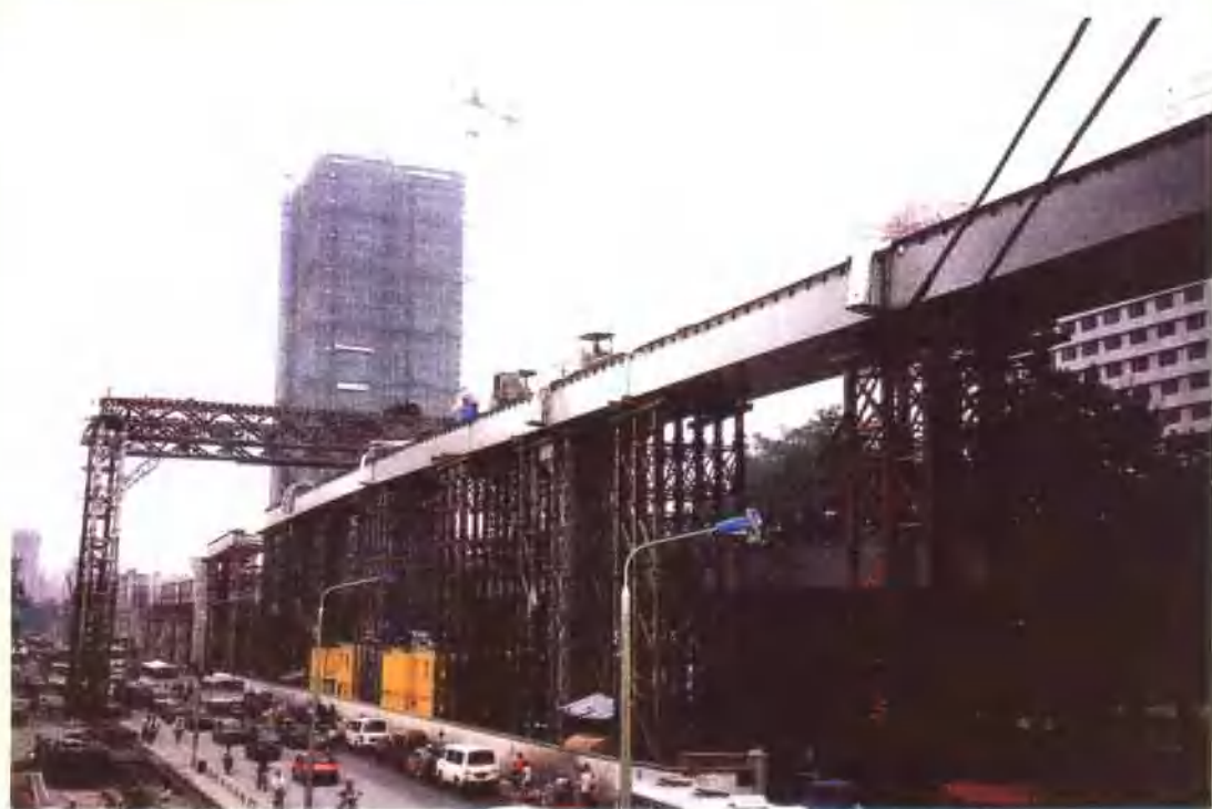
中山一路西段在施工中
