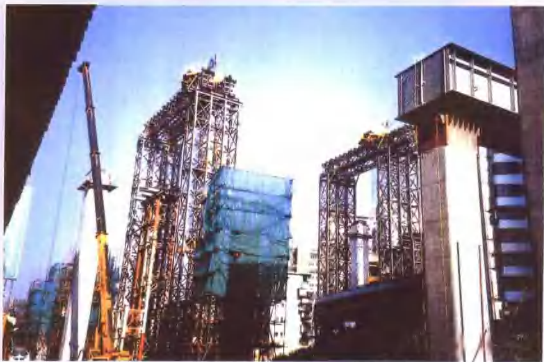
小北路立交在施工中
