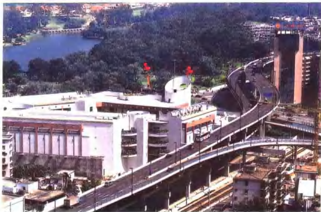
南湖路立交桥
