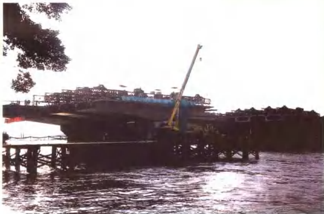
人民桥在施工中
