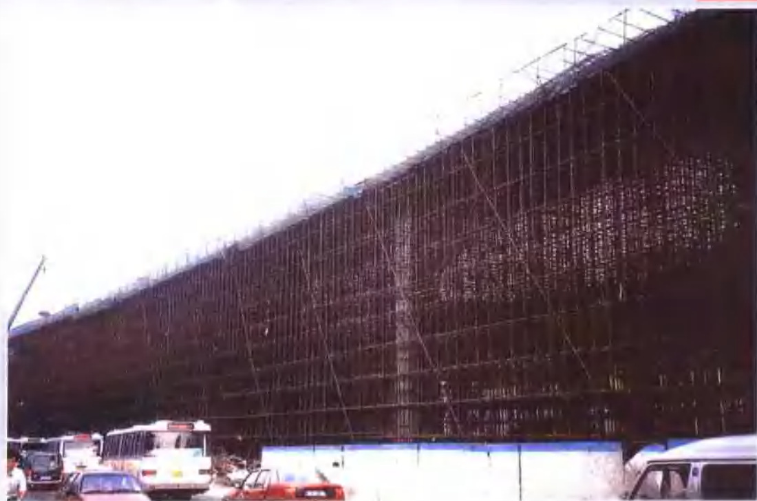
中山一路东段的高支顶架实况
