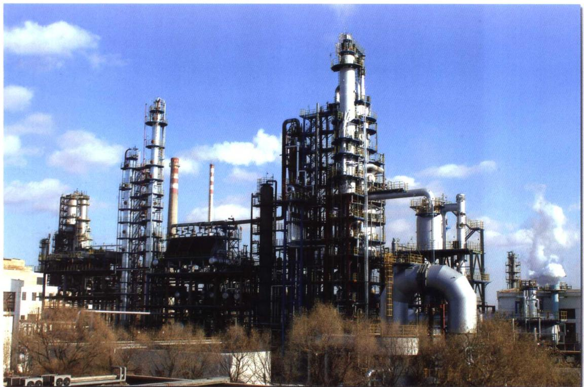
第二套催化裂化装置由中国石化洛阳设计院设计，1993年投产，历经数次改造后，反再系统装置采用单段逆流再生形式。装置处理能力50万吨/年。2005年10月，为了满足生产低烯烃汽油、兼顾多产低碳烯烃的目标，应用石油化工科学研究院的MIP技术对装置进行了降烯烃技术改造，改造后装置处理能力达到了60万吨/年，产品质量控制更加灵活，为公司产品质量升级打下了坚实的基础。
