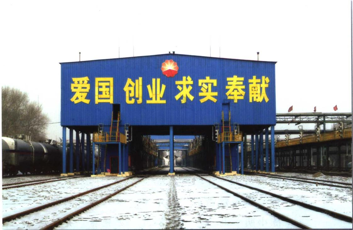
2005年，哈尔滨石化公司建设了汽柴油密闭浸没式外液压栈桥大鹤管自动计量装车系统。工程共建有2座栈台，8个大鹤管，分布于第二栈桥和第三栈桥，可以实现4个大鹤管同时装车的生产任务。此项目实现了汽柴油自动装车计量，提高了储运系统的自动化水平，降低了油品计量误差，改善了工人的劳动环境，同时为下一步的油气回收奠定了基础条件。
