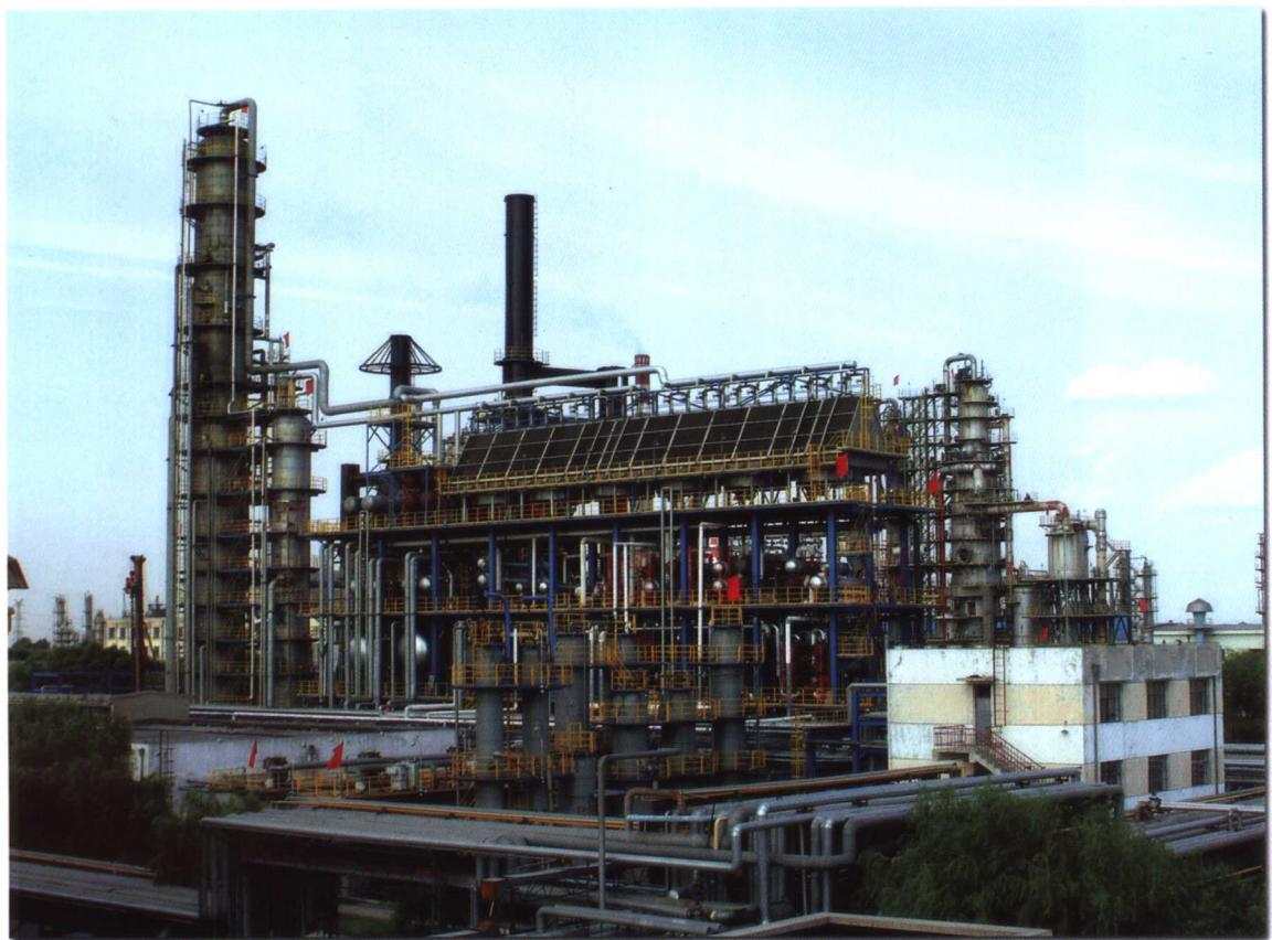
第一套常减压蒸馏装置加工能力350万吨/年，以大庆和俄罗斯混合原油为原料，生产石脑油、3#喷气原料、轻柴油、重柴油及常底渣油等产品。自2000年7月至2005年7月成功实现了5年一大修的长周期运行目标。2005年8月实施了节能技术改造，优化了换热网络，改造后，原油换热终温提高了30℃，装置能耗降低了近1个单位。
