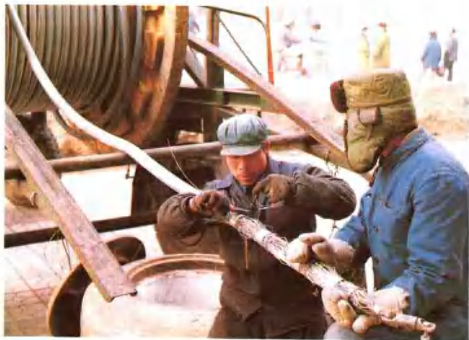
市内电话线务员铺设地下电缆
