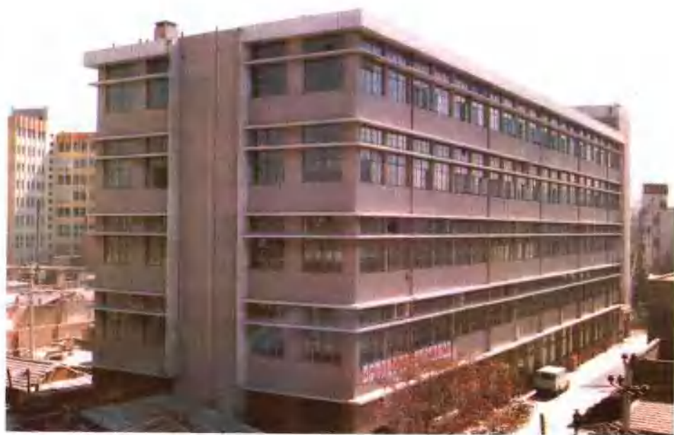
长途电信枢纽楼
