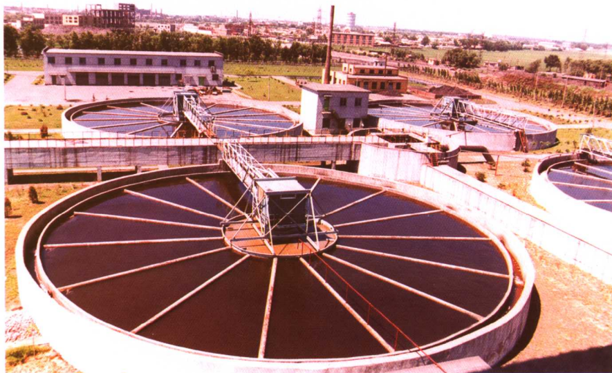
鞍山西部第一污水处理厂
