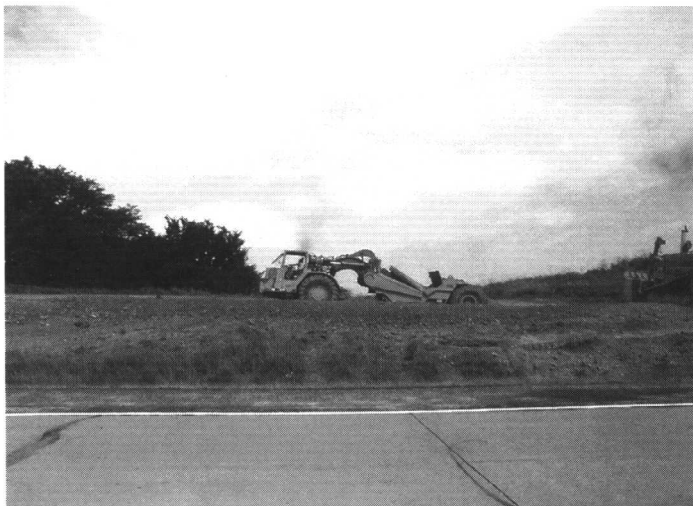
图 1.1 高速公路的施工现场，这里的表土可能不太令人满意
