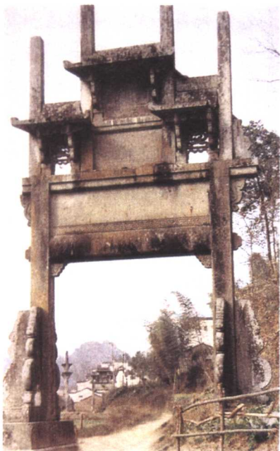
安徽黄山洪坊村石牌坊
